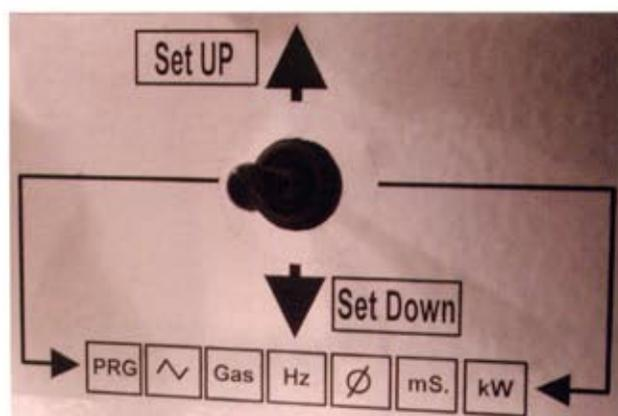
Fig. 6 joystick interno per la programmazione
